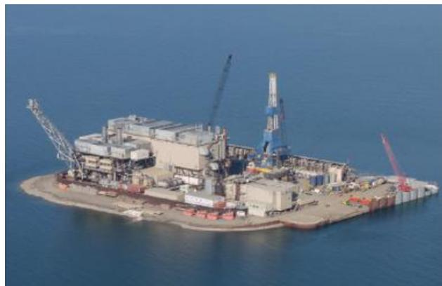
**Рис. 2. Гравийный остров месторождения «North Star» в процессе строительства (слева) и после**
